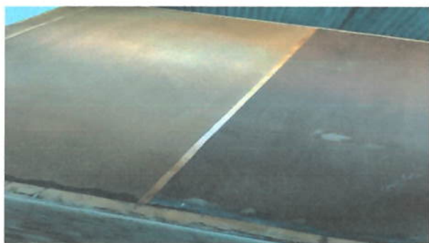
FOTO3: SUSTITUCIÓN DE ESTRUCTURA
