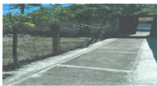
FOTO4: CERCO O MURO PERIMETRAL
