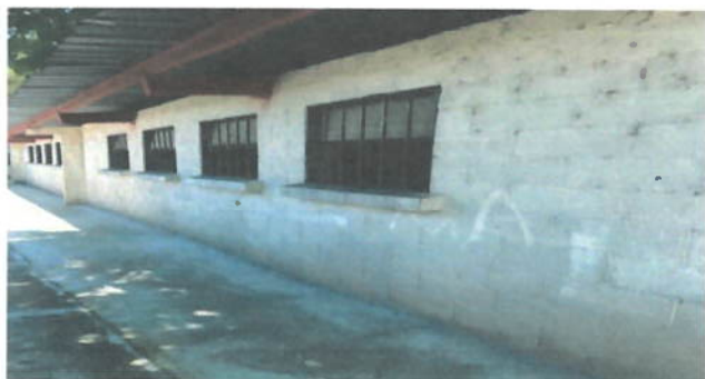
FOTO1: PINTURA EN MUROS INTERIOR Y EXTERIOR
